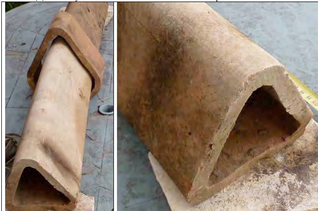
Photos 6,7, et 8 du système de transfert d'eau en terre cuite présent sur toute la zone.
