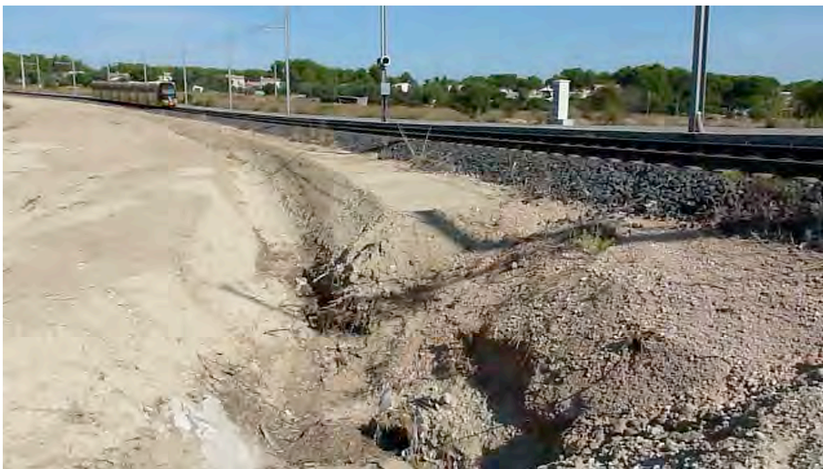
Photo 3. L'évacuation des eaux par un conduit de 40 cm de diamètre (à moitié obstrué) passant sous la ligne de tramway à l'Est de mas de Caylus.
